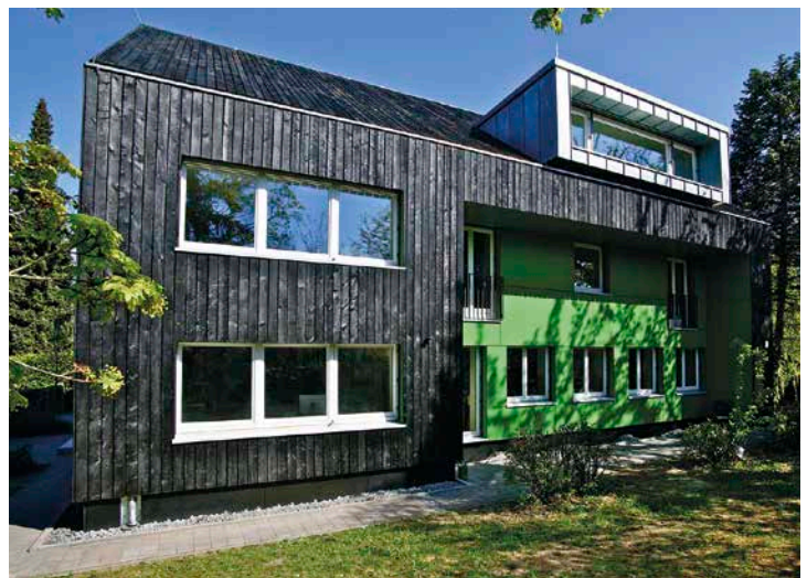
Rückansicht der sanierten Fassade des AELF Schweinfurt
