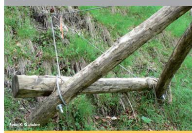
Schneefix Trio an einem in den Fels gebohrten Gewindestab-Anker – das hält!
