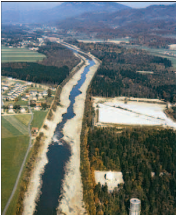
Abb. 4: Sohldurchschlag südlich von Salzburg (Foto: Ständige Gewässerkommission nach dem Regensburger Vertrag)
