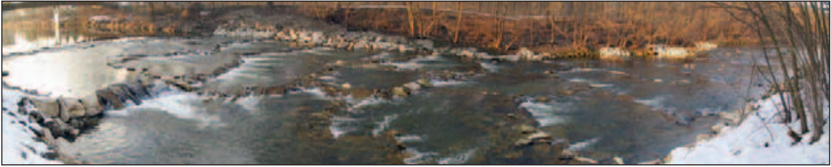
Abb. 6: Beispiel für eine aufgelöste Sohlrampe (Mangfall bei Rosenheim) (Foto: Wasserwirtschaftsamt Traunstein)
