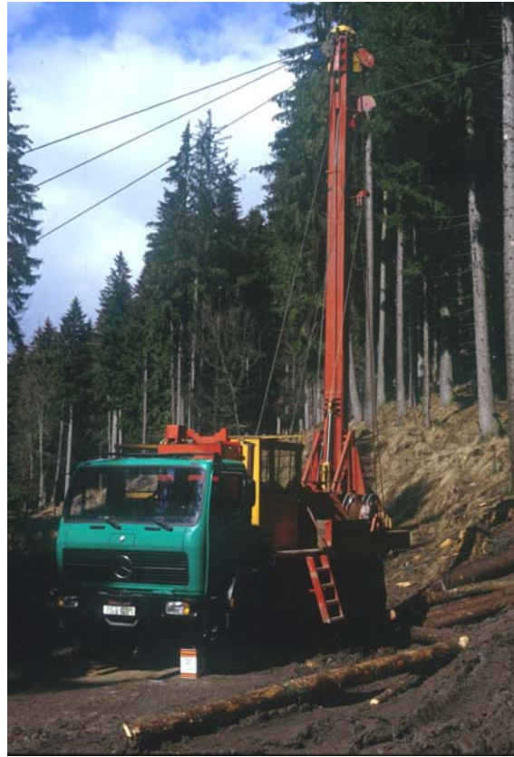
Abb. 16: Kippmasteanlage „K 800“ (Photo: LWF)
