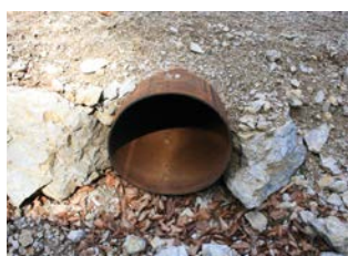
Entwässerungswanne zur talseitigen Wasserableitung.
