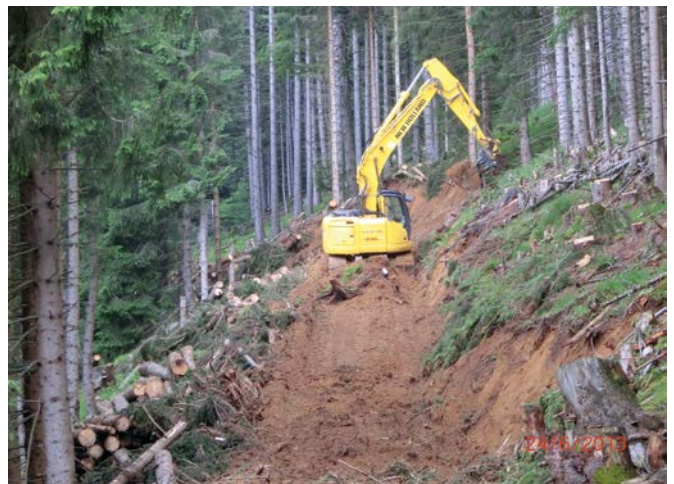
Herstellung des Wegeplanums und der Böschung durch Raupenbagger.
