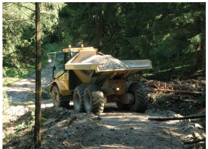
Materialtransport zur mechanischen Bodenverbesserung durch Muldenkipper.
