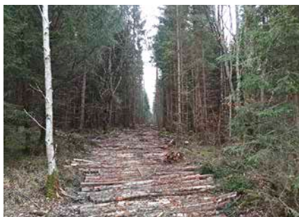
Bauweise »Prügelweg«, hier als temporäre Variante, aber auch bewährt auf Weichböden als Unterbau von Forstwegen.
