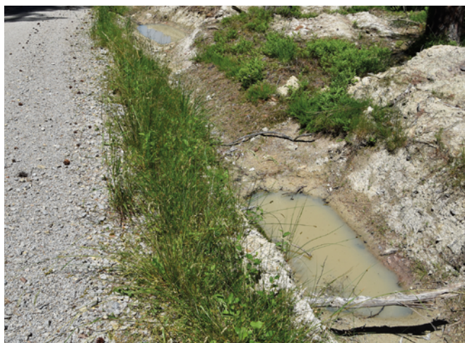
Kleingewässer können mit wenig Aufwand z.B. durch eine kaskadenartige Profilierung in Wegseitengräben angelegt werden.
