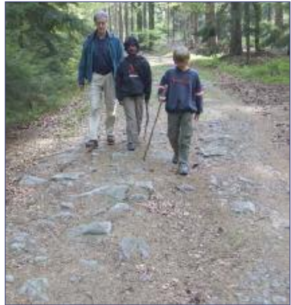
Der Böhmweg zählt zu den ältesten Verbindungen zwischen Donau und Moldau. Er führte wohl schon in der Keltenzeit als ausgetretener Fußweg über den Nortwald. Im 18. Jahrhundert wurde er mit Granitplatten befestigt, damit er von Kaufleuten mit Planwagen befahren werden konnte.
