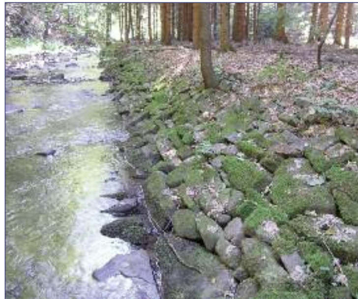
Im Frankenwald, hier der Landleitenbach bei Rothenkirchen, wurden im Verlauf der Jahrhunderte fast alle Floßbäche so stark verbaut, dass sie streckenweise noch heute den Eindruck von kleinen Kanälen machen. Durch Uferbefestigung aus Bruchsteinen und stellenweise sogar Pflasterung der Bachsohle sind die Bäche auf Teilstrecken regelrecht „versteinert“.
