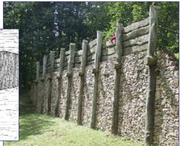
Auf dem Donnersberg in der Pfalz befindet sich eine Rekonstruktion einer Pfostenschlitzmauer. Die keltische Stadtanlage dort ist auch ein gutes Beispiel für den Denkmalschutz, denn das großräumige Areal wurde schon früh vom bayerischen Königshaus erworben und durch Wald geschützt.
