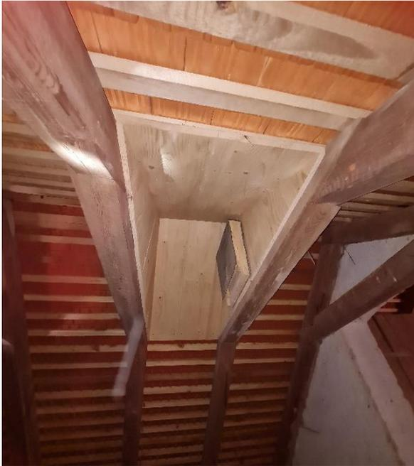
**Abb. 18:** „Wärmeglocke“ mit kleinem Flachkasten im Nebengebäude Schlott.
