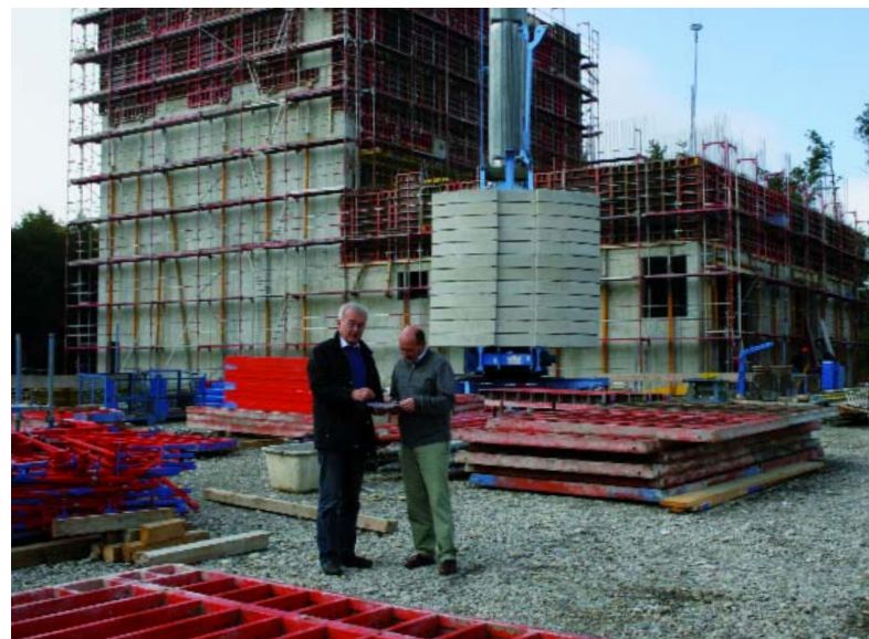
Dr. Klaus Bühler (li.) und Winfried Plaß (re.) vor dem Rohbau des neuen Hackschnitzelheizkraftwerks (Foto: F. Burger)
