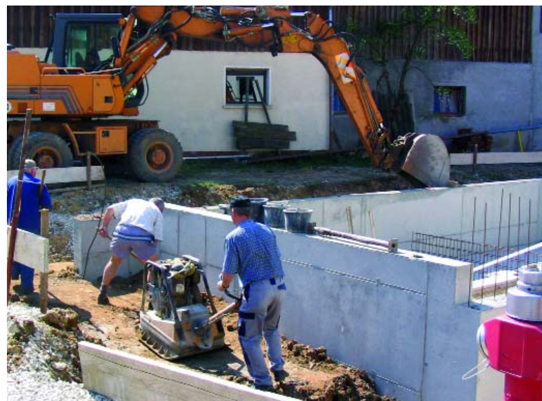
Abbildung 2: Für die gemeinsame Energieversorgung erbrachten die Bürgerinnen und Bürger über 5.000 Arbeitsstunden in Eigenleistung
