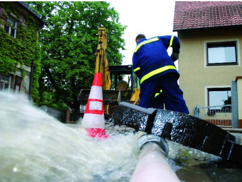
Abbildung 1: THW-Helfer aus Forchheim pumpen vollgelaufene Kellerräume aus. (Foto: S. Mühlmann/THW)
