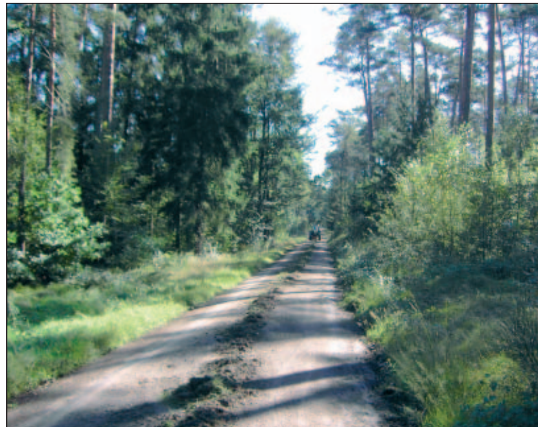
Abb. 2: In die Fahrbahnmitte geschwadetes Material (Foto: Hölldorfer)
