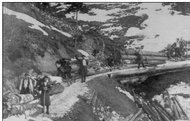
Abb. 4: Im 19. Jahrhundert wurden Schlittenwege im Hochgebirge angelegt. Aperte der Schnee aus, wurde er von Hand auf die Wege geschaufelt, um möglichst bis ins späte Frühjahr Holz bringen zu können. (Foto: Archiv des Holzknechtmuseums Laubau)
