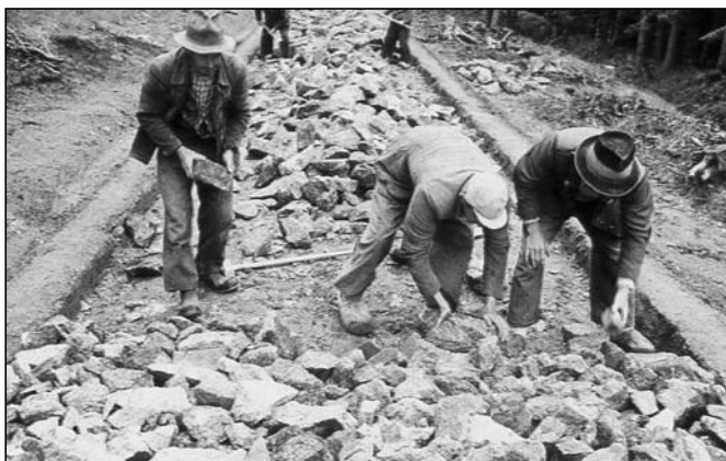
Abb. 3: Bau eines der letzten Wege in Bayern in Setzpacklage in den 1950er Jahren bei Ruhpolding (Foto: Lehrstuhl Forstl. Arbeitswissenschaft)
