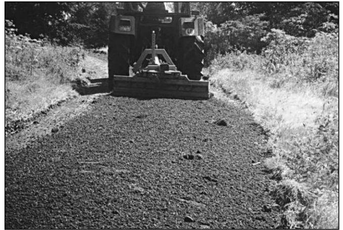
Abb.4: Verteilen des Verschleißmaterials aus der Fahrbahnmitte in die Fahrspuren mit der Eisenschiene in geänderter Schildein­stellung
