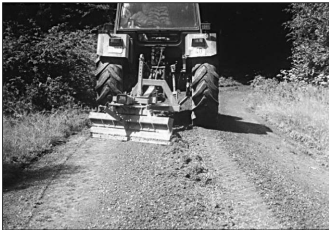
Abb. 3: Hereinholen von Material der Verschleißschicht
