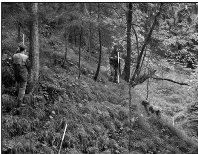
Abb. 3: Die Trasse wird verpflockt. (Foto: G. WAAS)
