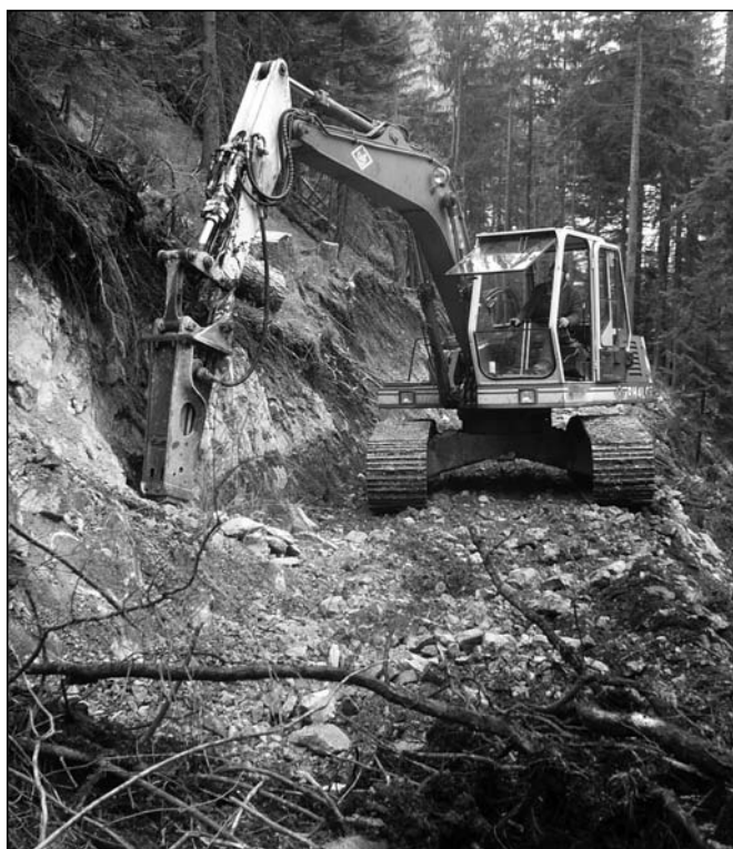
Abb. 4: Mit einem Bagger wird das Rohplanum schonend erstellt. (Foto: G. WAAS)
