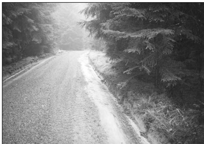
Abb. 1: Ergebnis der Instandsetzungsmaßnahme eines Grabens mit dem Grabenbagger (Foto: J. SCHMAILZL)
