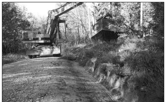
Abb. 1: Der Grabenbagger im Einsatz (Foto: J. SCHMAILZL)
