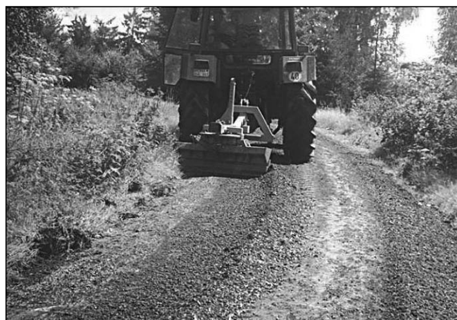
Abb. 1: Das R 2-Gerät im Einsatz beim Wegeunterhalt (Foto: U. SCHMIDT)
