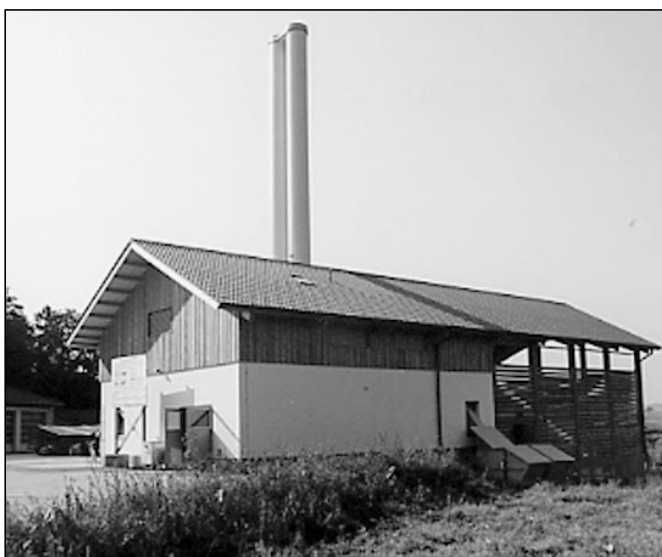
Abb. 6: Biomasseheizwerk Bad Endorf (Quelle: C.A.R.M.E.N. e.V.)
