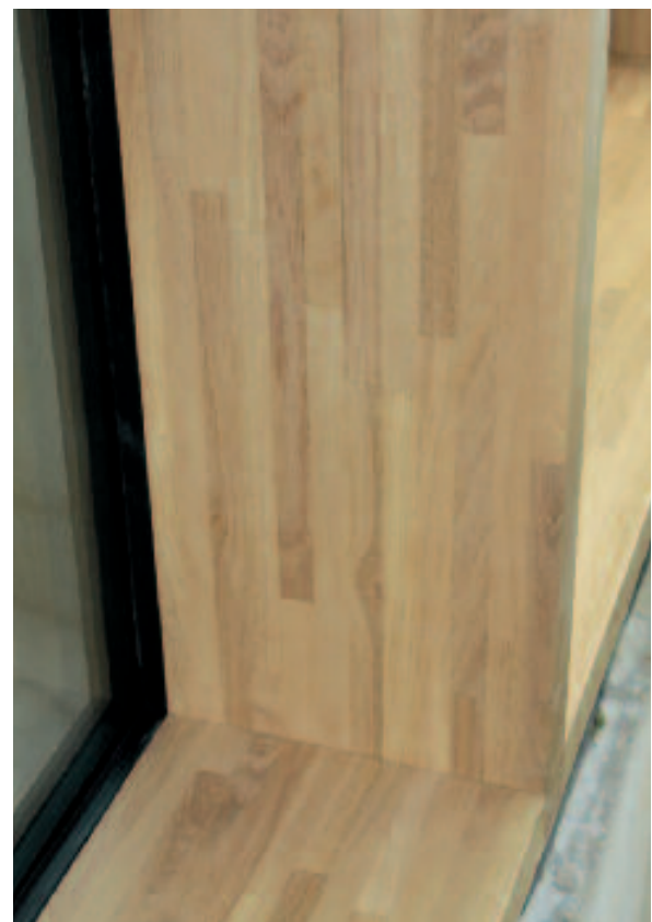
Abbildung 16: Eichen-Pfosten-Riegel
