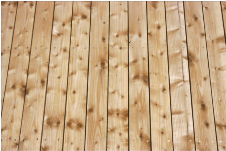
Abb. 4: Hochwertige Tanne als Fassade (Foto: Lutze)
