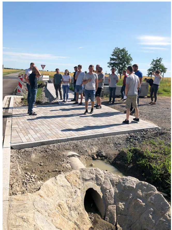
▣ Bild 1: Hochwasserschutz durch Flutmuldenbau – Das System leitet über differenzierte Durchlass-Bauwerke das Überschusswasser in Mulden, einen Teich und schließlich per Notüberlauf in ein Gewässer (Foto: FNO Fröhstockheim)
