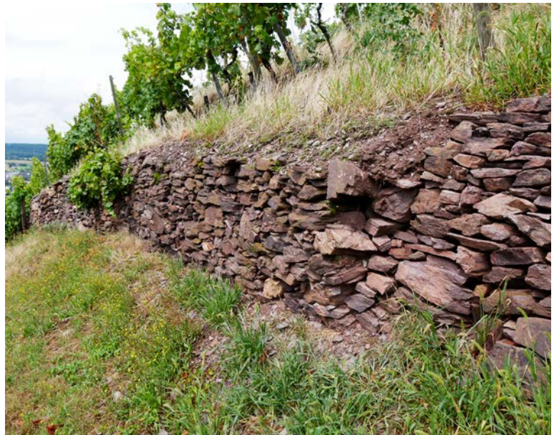
Bild 1: Trockenstützmauern in den Weinbergen (d. h. unverfugte Bruchsteinmauern in Hängen aus lokaltypischem Naturstein mit direktem Bodenanschluss sind wichtige ökologische Nischen für viele Weinbergsbewohner. Die Restaurierung und der Neubau unverfugter Trockenmauern sind förderfähig (Trockenstützmauer in Michelbach-Alzenau, Unterfranken) (Fotos: LWG)
