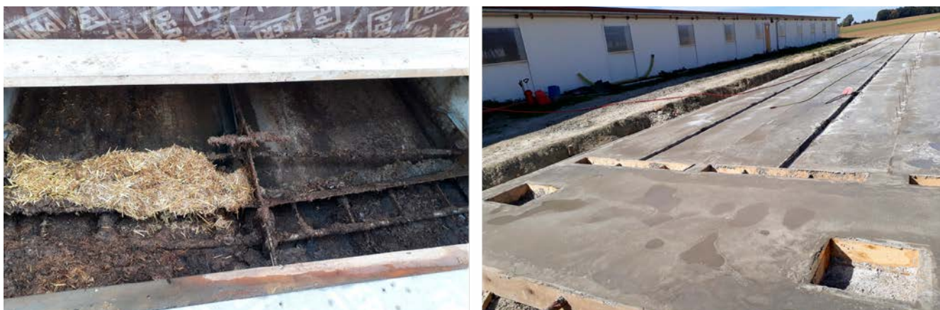
▭ Bild 4: Unterflurschieber mit Kot-Harn-Trennung im Rohbau (rechts) und in Betrieb (links)
