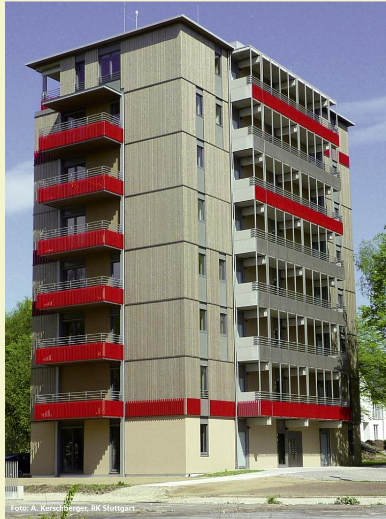
Abbildung 4: 8-geschossiges Mehrfamilienhaus in Holzbauweise auf dem Null-Emissions-Quartier im oberbayerischen Bad Aibling
