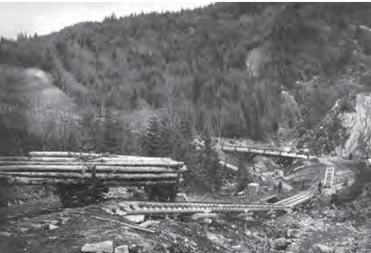
**1** Die Bremsbergbahn brachte vom »Bahnhof« auf ca. 1.050 üNN das Holz mit einem durchschnittlichen Gefälle von 25 % ins Tal. Durch die Schwerkraft des vollen Waggons wurde der leere Waggon nach oben gezogen, also ohne Motor. Es wurde daher nur gebremst. Quelle: Gemeindeforschung Schwaigen-Grafenaschau
