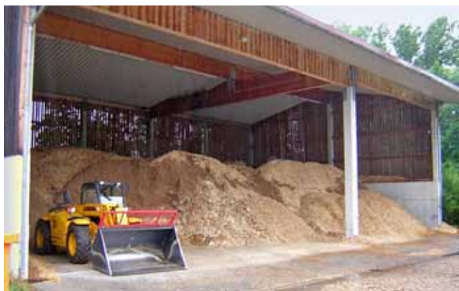
Vorbildliche Lagerhalle (Foto: LWF)
