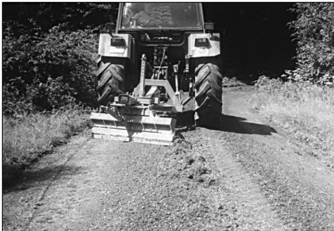
Abb. 3: Hereinholen von Material der Verschleißschicht
