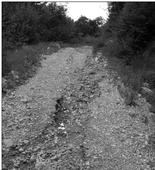
Abb. 1: Erodierter, aber noch nutzbarer Forstweg in Montenegro (Foto: W. GUGLHÖR)
