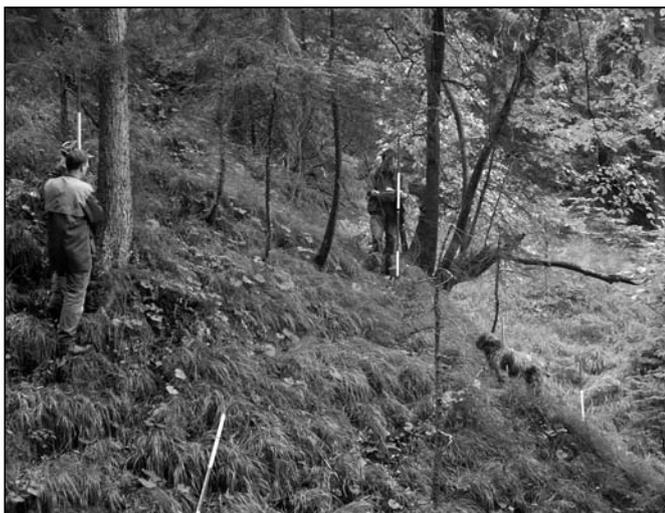
Abb. 3: Die Trasse wird verpflockt. (Foto: G. WAAS)
