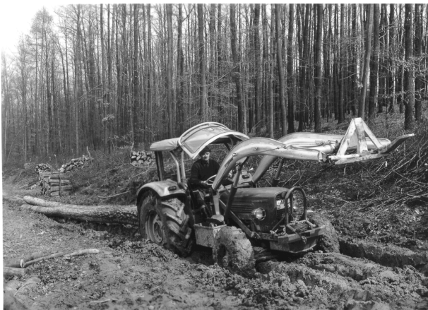
Abb. 1: Holzernte in den 1960ern: Landwirtschaftlicher Schlepper mit schmalen Reifen; Bodenschäden spielten keine Rolle (Foto: Archiv Lehrstuhl für Forstliche Arbeitswissenschaft).
