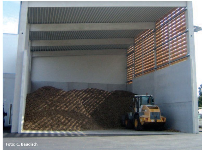
Abbildung 2: Im Hackschnitzellager des Biomasse-Heizkraftwerks Mertingen können circa 1.000 Schüttraummeter Waldhackschnitzel mit einem Energieinhalt von etwa 1.000 Megawattstunden gelagert werden.
