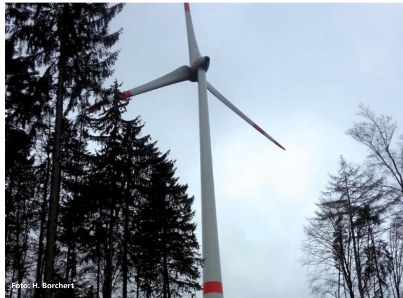
Abbildung 4: Hoch über den Baumkronen drehen sich die Windräder – Eine neue Energiequelle in Wäldern.
