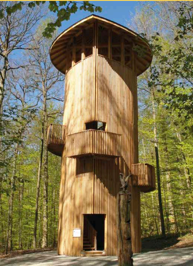
3 Eichenturm im Guttenberger Forst: Der Eichenturm ist eine echte Bereicherung eines vorhandenen Walderlebnispfad: Nachhaltiges Bauen, Nutzen und Schützen, Waldnaturschutz, Lebensraum Baumkrone – all dies lässt sich mit und in diesem Bauwerk hervorragend veranschaulichen und begreifbar machen
