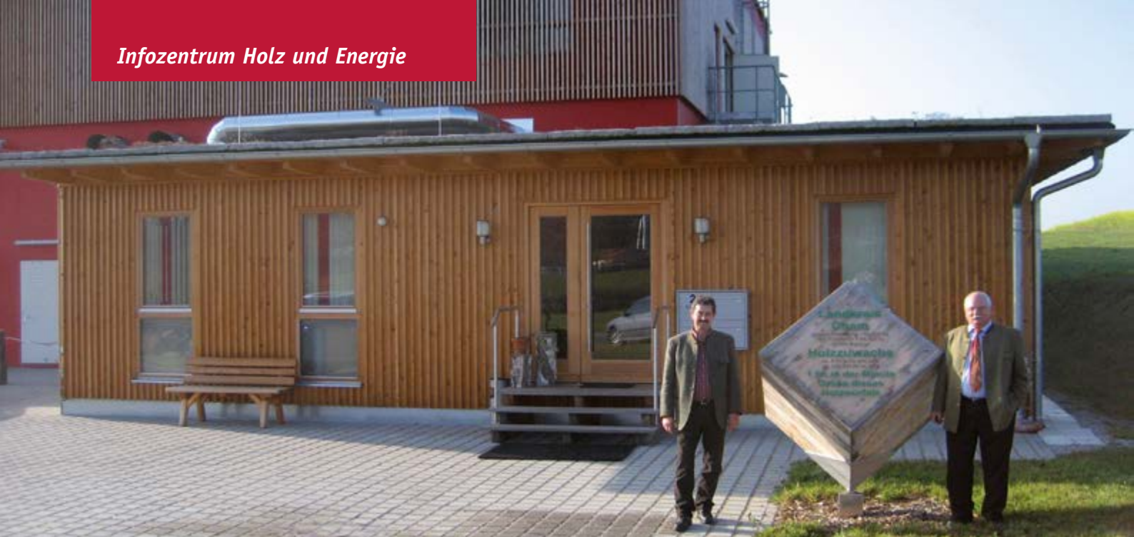
Im neuen direkt neben dem Biomasseheizkraftwerk gelegenen Infozentrum gibt es Informationen aus erster Hand.
